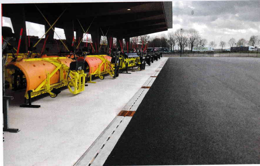
Bild 1: Bei der Sanierung wurden Schlitzrinnen aus dem Betonwerk Rinninger verwendet, die auch in Bereichen mit wassergefährdenden Stoffen eingesetzt werden dürfen (Foto: Jura bv)
