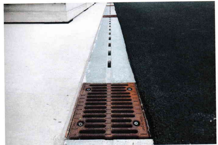
Bild 2: Der Werkstoff RIKI-CETON ist ein ultrahochfester Beton mit reduzierter Bewehrung (Foto: Jura bv)
